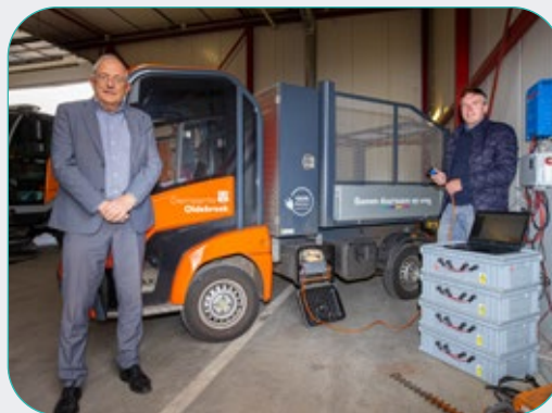
Proefproject op gemeentewerf Oldebroek met zon op dak, elektrische auto en zoutaccu.
