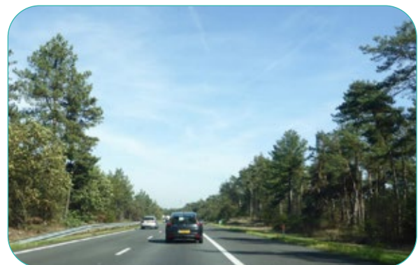
A28 als energieroute onderzocht.
