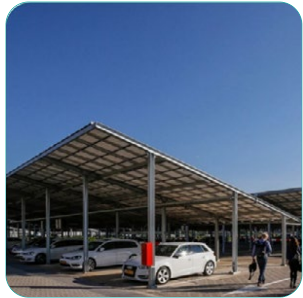
Parkeerterrein op defensie terrein, overkapt met zonnepanelen.
