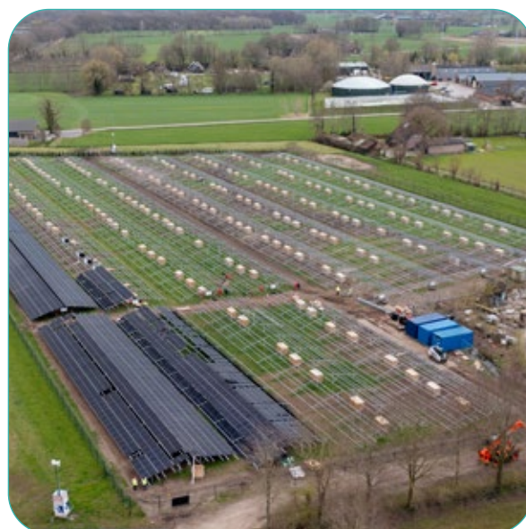
Aanbouw zonnepanelenveld bij Aalbertshoeve in Ermelo - april 2021
